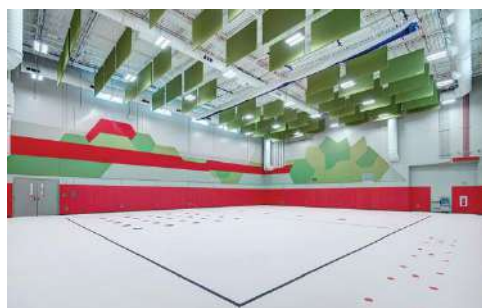
Εικόνα 6. Ακουστικά Πάνελ σε αίθουσα φυσικής αγωγής
