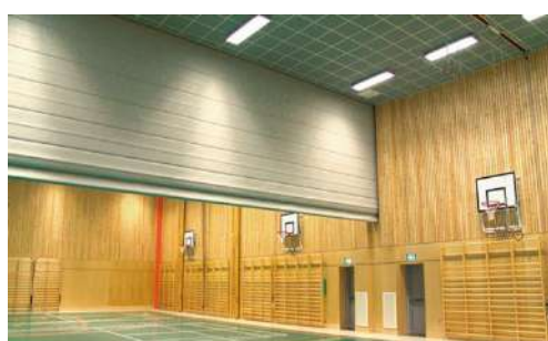
Εικόνα 7. Διαχωριστικός Τοίχος Ηχομόνωσης σε αθλητική αίθουσα σχολείου
